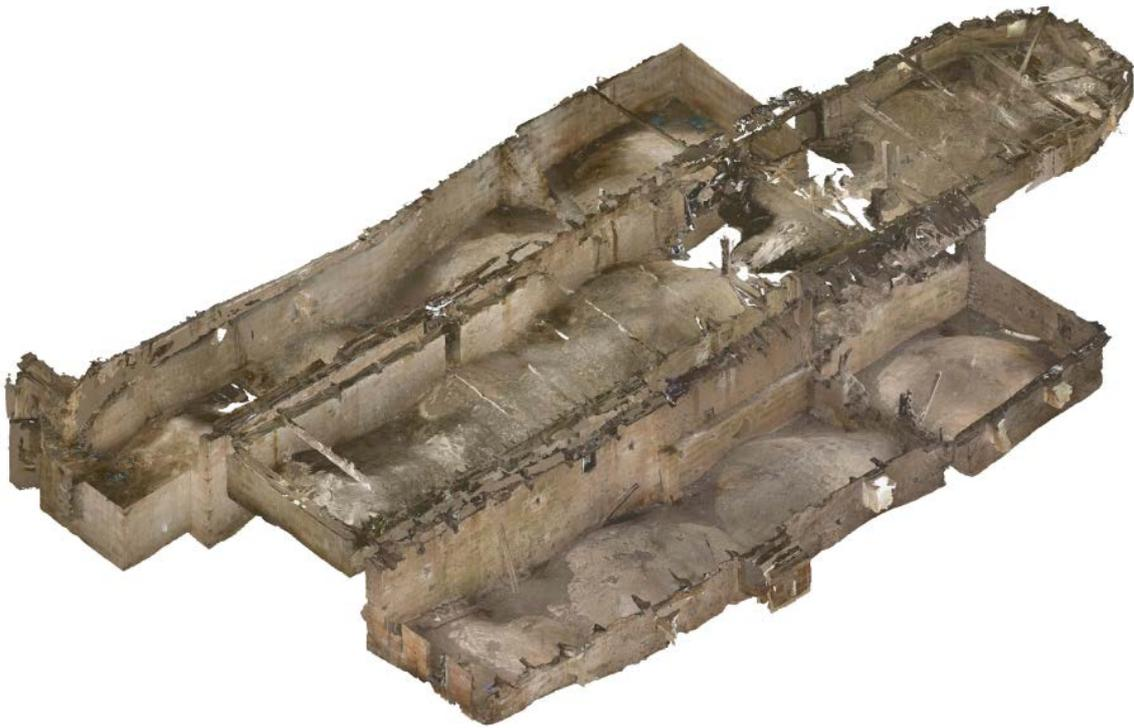
*Foto 3. Modelo 3D de las fábricas bajo cubierta y por encima de las bóvedas.*
