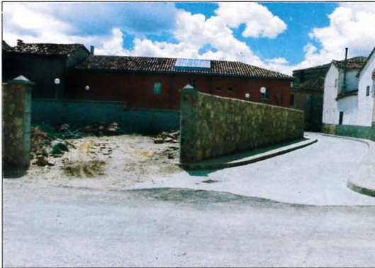
CANALIZACION DE AGUA. DESAGÜES. PAVIMENTACION Y NUEVAS PAREDES DE PIEDRA. C/ HIERRO Y TRAVESIA HIERRO.
