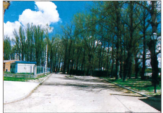
ACONDICIONAMIENTO PARQUE CAÑAMARES, ILUMINACION Y DESAGÜES DE PLAZA DE TOROS Y LINEA DIRECTA DE TENSION EN FIESTAS.
