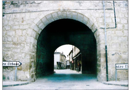
REHABILITACION ARCO DE LA CARCEL
