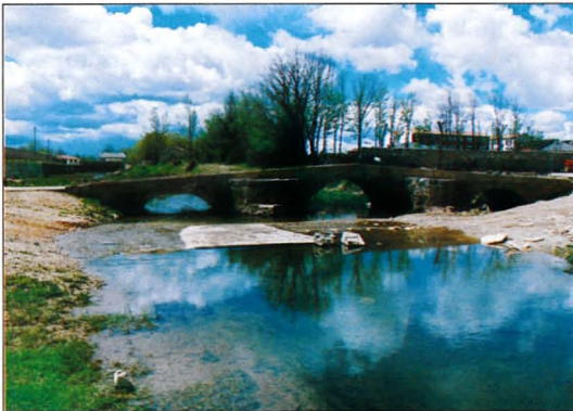
RESTAURACION DEL PUENTE ROMANO Y MUROS DE CONTENCION EN EL RIO.
