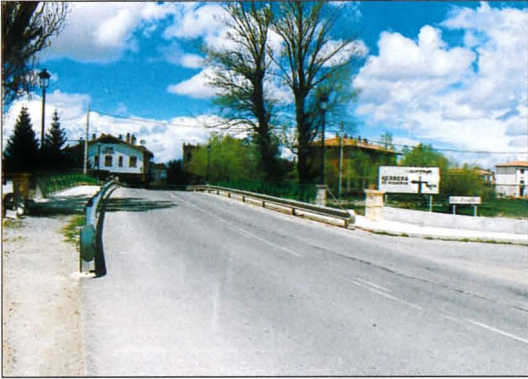
ULTIMAMENTE SE ESTA PROCEDIENDO A PONER MUROS Y VERJAS EN EL PUENTE Y PASEO PISCINAS.
