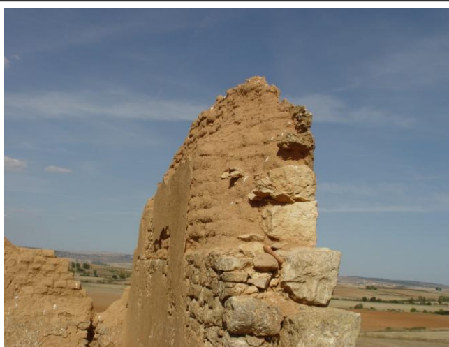
Foto 12.- Intersección de los muros Norte (fondo) y Este (primer plano). En el flanco del muro este se puede ver la relación de tres unidades con aparejos diferentes: sillería (UE 6), mampuesto (UE 21) y adobe (UE 7)
