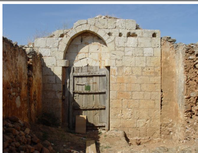
Foto 10.- Arco de carga en el lienzo interior oeste (UE 9)
