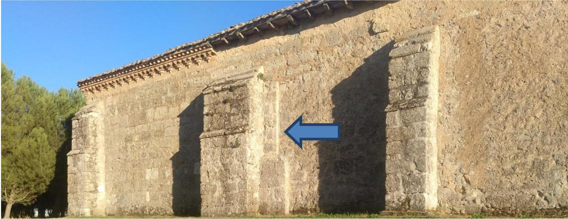
En la pared de la cara norte hay cuatro contrafuertes. El cuarto no aparece en la foto. El primero de la esquina mide 1,20 metros de ancho. El segundo, 1,70 metros y los otros dos, 0,85 y 0,80 metros respectivamente. Si os fijáis en la flecha azul podéis ver que se empalman dos obras distintas. La de los gruesos contrafuertes con la de los normales, de menor anchura.
