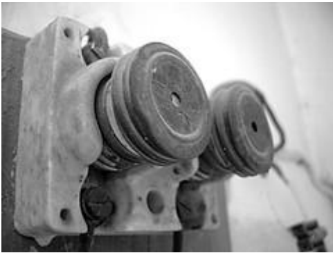
Plomos o fusibles del circuito
