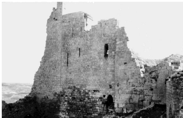
Restos del Castillo de Alfoz y Merindad de Castrojeriz
