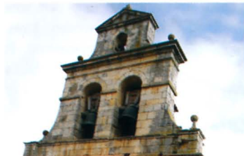
Iglesia de la Invención de la Sta Cruz por Sta Elena
