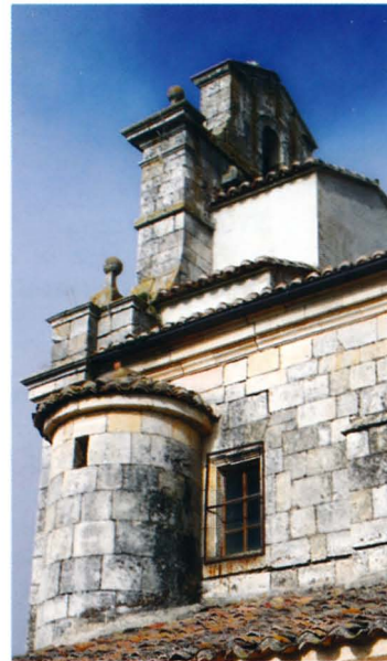
Iglesia de la Invención de la Sta Cruz por Sta Elena
