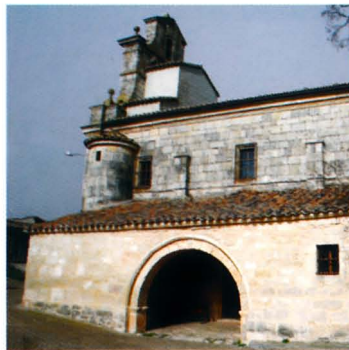
Iglesia de la Invención de la Sta Cruz por Sta Elena
