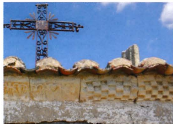
Cementerio: restos de ermita
