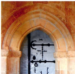
Pórtico de la Iglesia
