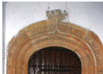
Pórtico de la Iglesia de San Martín de Tours
