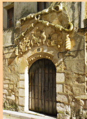
Valdecañas de Cerrato. Casa gótica
